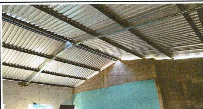
Foto 5: instalacion de lamina.
