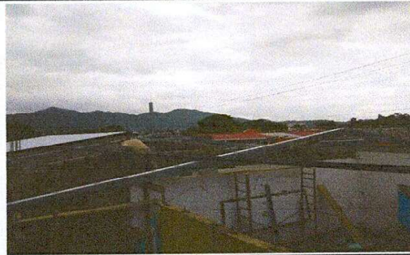
Foto 4: instalacion de estructura de techo.
