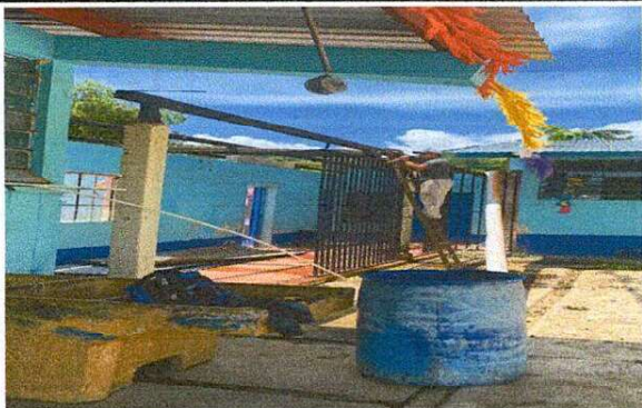
Foto1: Desmonte estructura de techo.
